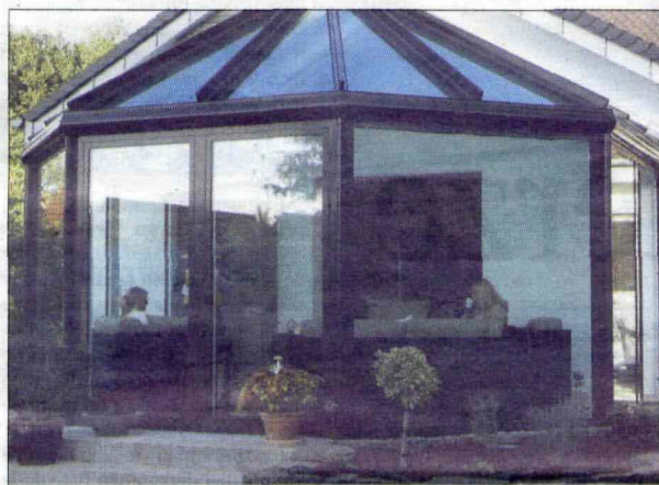
Duże, przeszklone powierzchnie pozwalają energii słonecznej wnikać do wnętrza. Dlatego to rozwiązanie jest popularne w budownictwie energooszczędnym.
